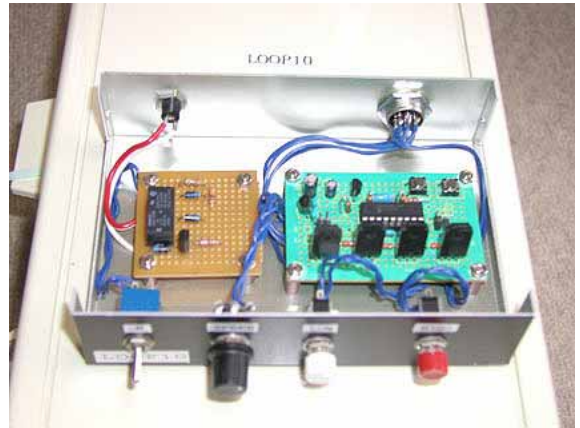
写真6. コントローラ内部
